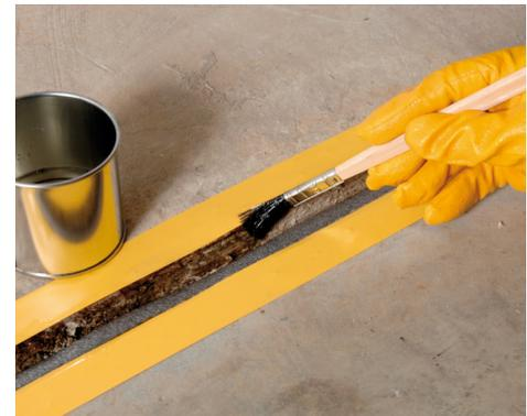
PCI Elastoprimer Uni verbessert die Haftung von PCI-Fugendichtstoffen auf den angegebenen Untergründen.
